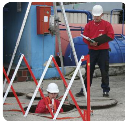
Kontrolle, Wartung und Generalinspektion von Abscheideranlagen sind wichtig. Es geht dabei um Gewässerschutz und Sicherheit.
